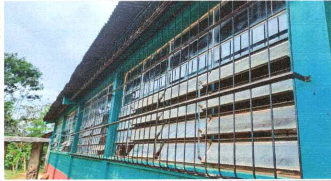
Foto 7. Sustrucion de ventanas
