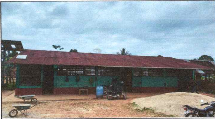
Foto 1. Sustitucion cubiertas de láminas
