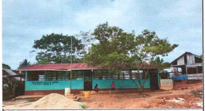
Foto 2. Sustitucion cubiertas de laminas
