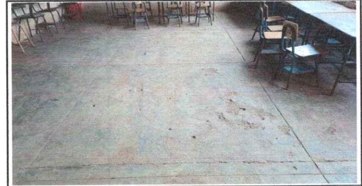
Foto 6. Sustitucion de pisos
