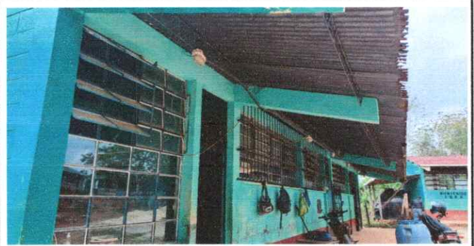
Foto 8. Reparacion de Balcones
